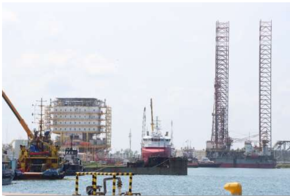
Fuente: Puerto de Dos Bocas https://www.puertodosbocas.com.mx/infraestructura
